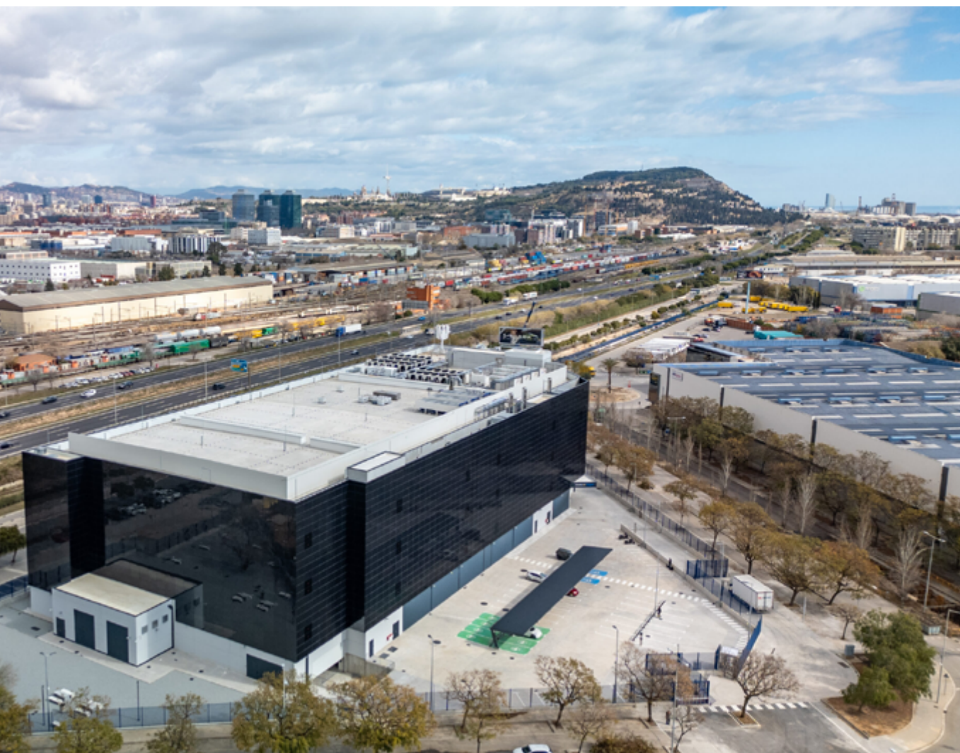
Centre de dades ubicat a la Zona Franca de Barcelona.
