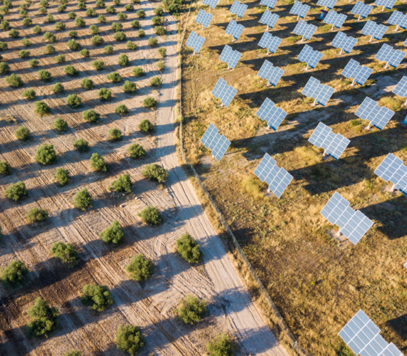
Vista aèria amb dron d'un camp de plaques solars i oliveres a les comarques de Lleida.
