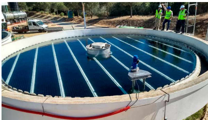
Rehabilitació a decantador lamel·lar en el vas d'una estació depuradora, a Portugal.
