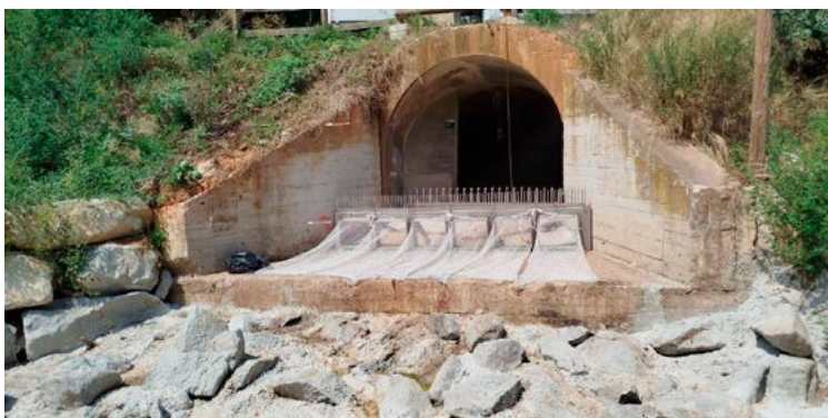
Instal·lació de xarxes Tecnograbber a la sortida d'un desguàs.
