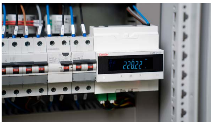
L'analitzador CVM-D400 ofereix una solució més avançada, capaç de monitorar múltiples circuits alhora i d'integrar-se fàcilment en sistemes de gestió energètica més amplis.
