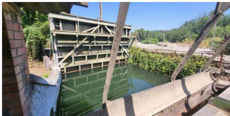
Comporta d'entrada a la central (part superior) i el neteja-reixes (part inferior).
