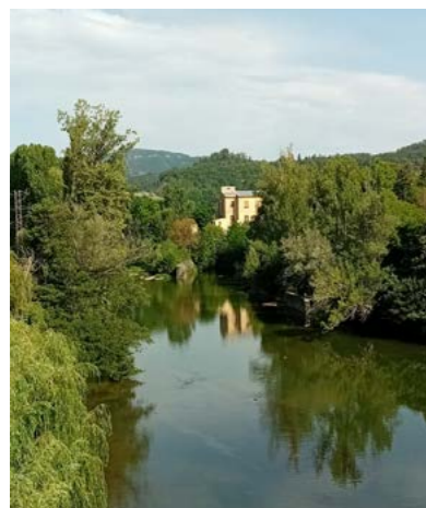
Vista general de la central des d'aigües avall.
