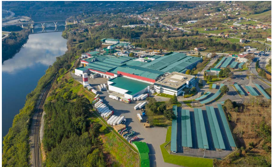
Vista aérea del Centro de Procesado Avícola de Grupo Coren en Santa Cruz de Arrabaldo
