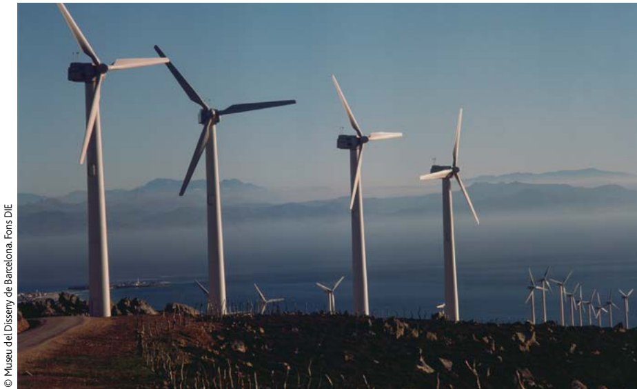
▲ Aerogeneradors 20/150 d'Ecotècnia instal·lats al parc eòlic de 10 MW de la Sociedad Eólica de Andalucía, a Tarifa, Cadis.
