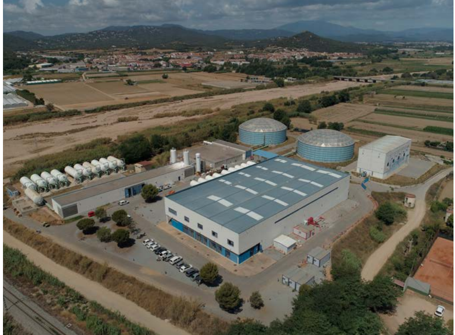
Vista aèria de la dessalinitzadora de la Tordera. Inaugurada el 2002 i ubicada al terme municipal de Blanes, és la primera dessalinitzadora de Catalunya. Té capacitat per a produir fins a 20 hm 3 /any d'aigua potable.
