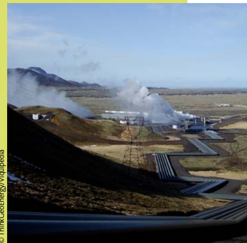
Central geotèrmica Hellisheidi, a Islàndia.
