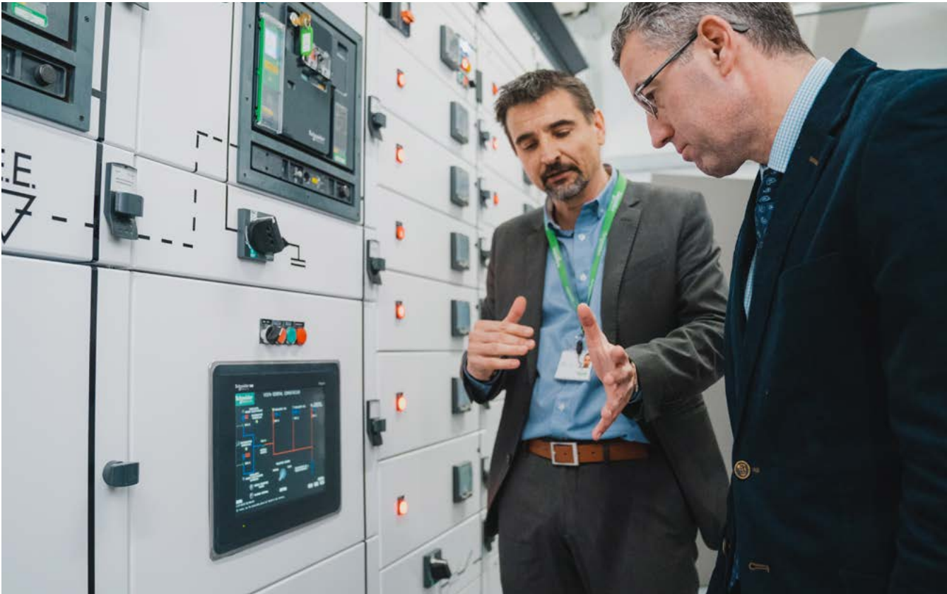
Comercial de Schneider Electric explicant el detall de les noves instal·lacions.
