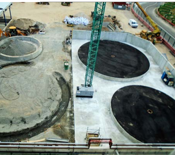
Vista de l'obra civil durant la preparació de les bases dels tancs.
