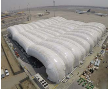
Procés de muntatge i inflament de l'hangar H75, instal·lat a Jiddah (Aràbia Saudita), que és encara l'hangar inflable més gran del món.
