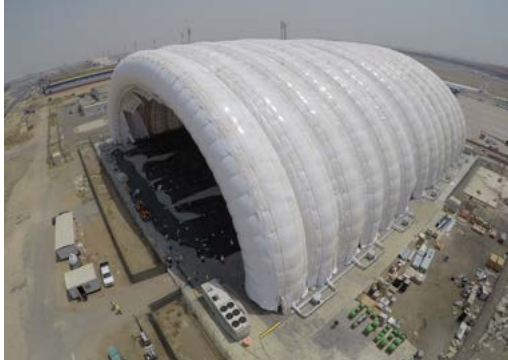
Procés de muntatge i inflament de l'hangar H75, instal·lat a Jiddah (Aràbia Saudita), que és encara l'hangar inflable més gran del món.
