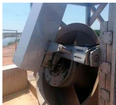
Sortida del cargol d'Arquímedes emprat per bombar l'aigua.
