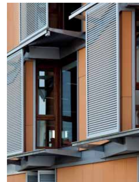
Les peculiars persianes de l'edifici són un dels sistemes utilitzats per optimitzar l'ús dels recursos naturals i estalviar energia.
