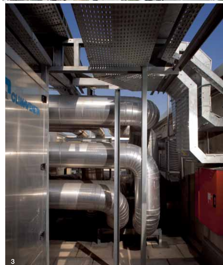
1 Secció longitudinal de l'edifici A. 2 Vista aèria de les noves instal·lacions de l'Hospital de Sant Pau. 3 Xarxa de canonades de circuits primaris de climatització a la coberta. 4 Safates elèctriques a la coberta.
