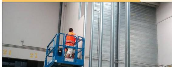
Sistema High Stil para tabiques de gran altura, alcanzando hasta los 10 metros de altura, con un EI de hasta 120 minutos.
