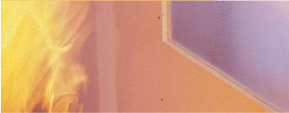
Sistema de partición vertical permite sectorizar dos recintos con protección al fuego. EI 120 minutos compuesto de una estructura y doble placas Knauf Cortafuego de 12,5 mm.
