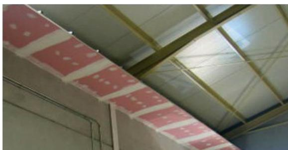
Los paneles de cartón yeso están compuestos por una alma de yeso especial recubierta por láminas de fibra de vidrio incombustible. Eso les confiere rigidez en todo el conjunto. Obtienen mayor facilidad de manipulación en la instalación.
