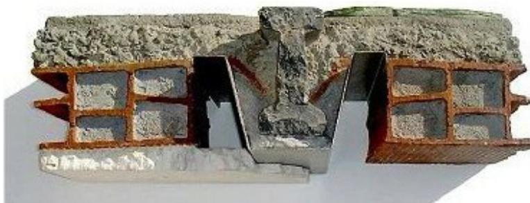
Se trata de perfilería metálica de grosor fino que envuelve el perfil a sustituir (sin quitarlo) y el vacío que queda entre el perfil y el envolvente se rellena con cemento celular (véase la foto de la viga de hormigón sustituida).
