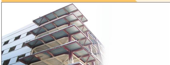
Protección de forjados de chapa colaborante con mortero de yeso Igniver para reducir la transferencia térmica y conseguir hasta REI 120.
