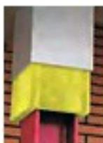
Por lo tanto, se debe tener presente que el cálculo del factor de forma no es el mismo cuando se valora la protección con placas o paneles, que cuando se valora la protección con pintura o mortero.
