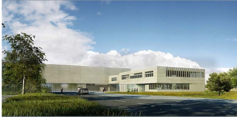
Data Center Bastogne Luxemburgo
